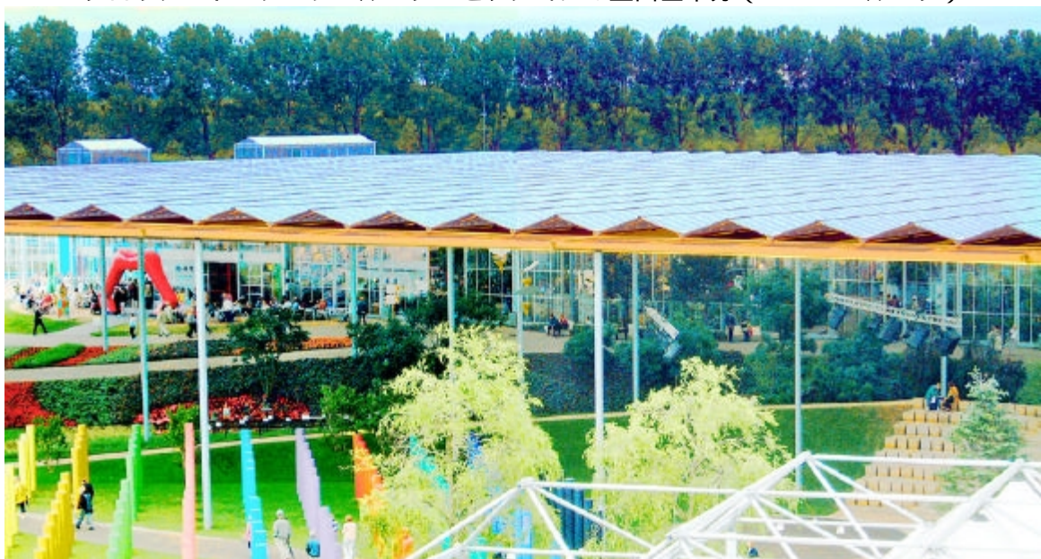
2.3MWPV ルーフ上面 ( 正面左半分 ) ( 東向き傾斜と西向き傾斜があり、前面が南向きからずれているので一方に日陰ができる )
