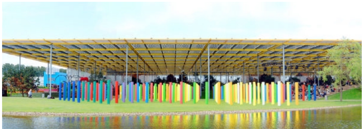
フロリアード・ソーラールーフ・セクションの正面左半分 ( 2.3MWPV ルーフ )
